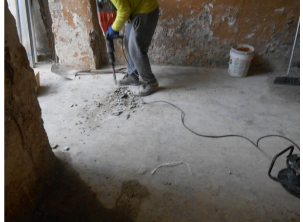
FOTO 6. Inici de les tasques de rebaix a l'interior de l'immoble
