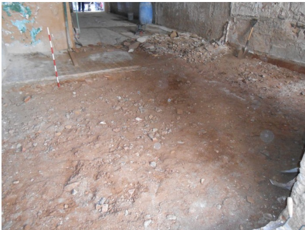
FOTO 7. Detall del rebaix a l'interior de la finca
