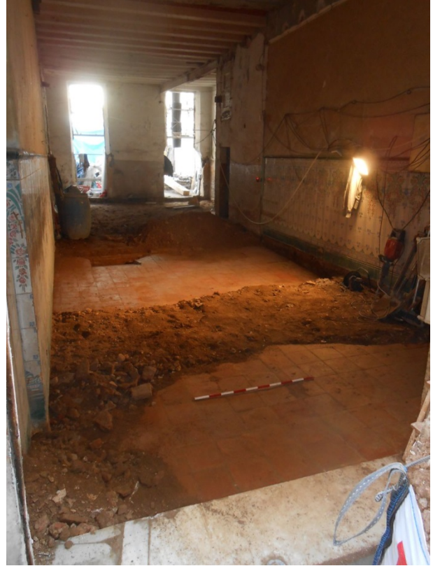
FOTO 12. Vista general del paviment UE 104
