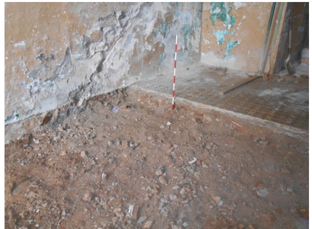
FOTO 8. Detall del rebaix a l'interior de la finca
