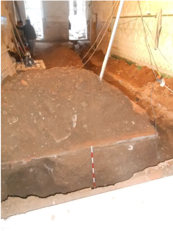
FOTO 17. Vista general de la rasa de sanejament
