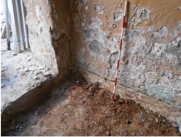
FOTO 23. Detall del rebaix
