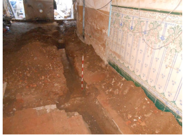
FOTO 16. Vista general de la rasa de sanejament
