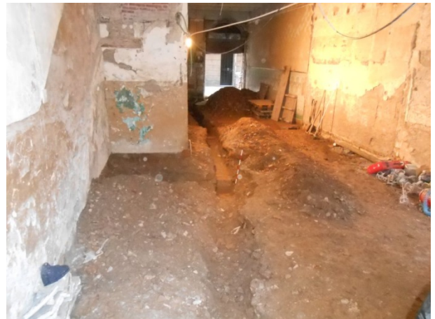
FOTO 18. Vista general del la rasa de sanejament
